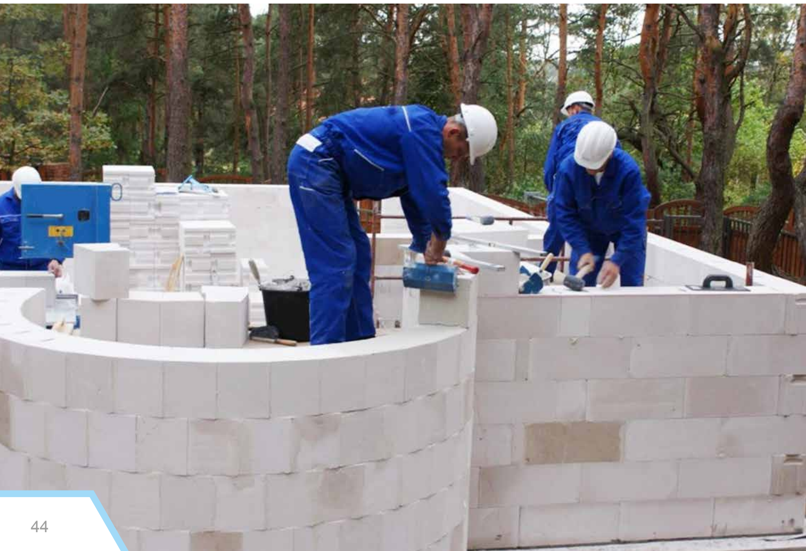
Ilustracja 42: Ściany z bloczków z betonu komórkowego
