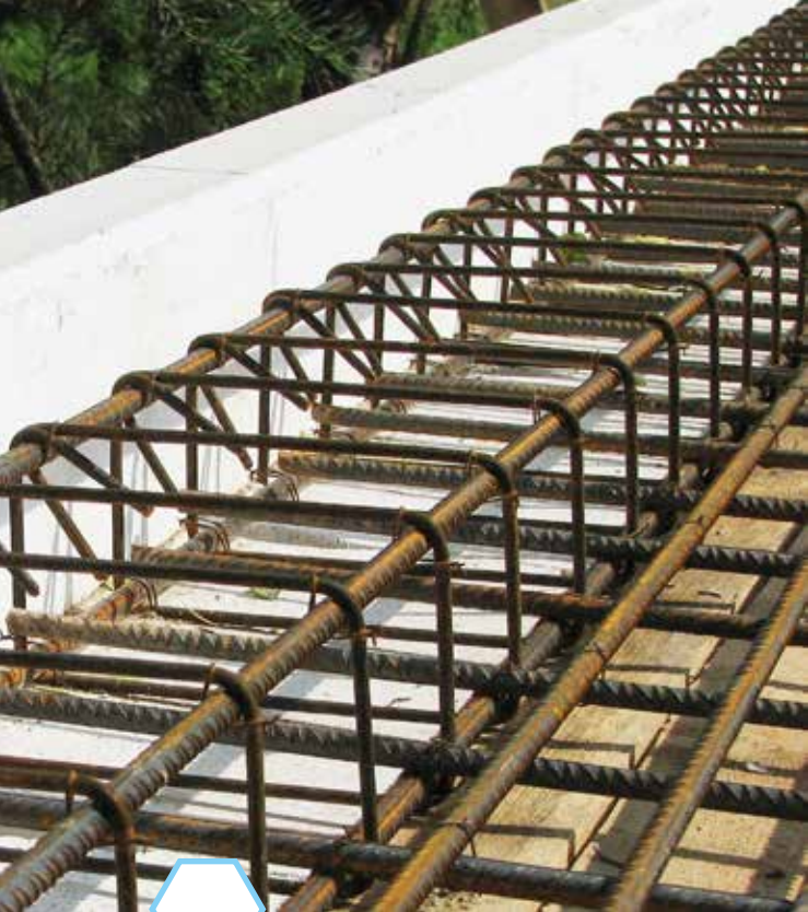
Ilustracja 15: Detal prawidłowego rozwiązania mostka termicznego
